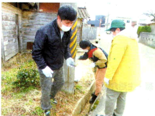
側溝もチェック
